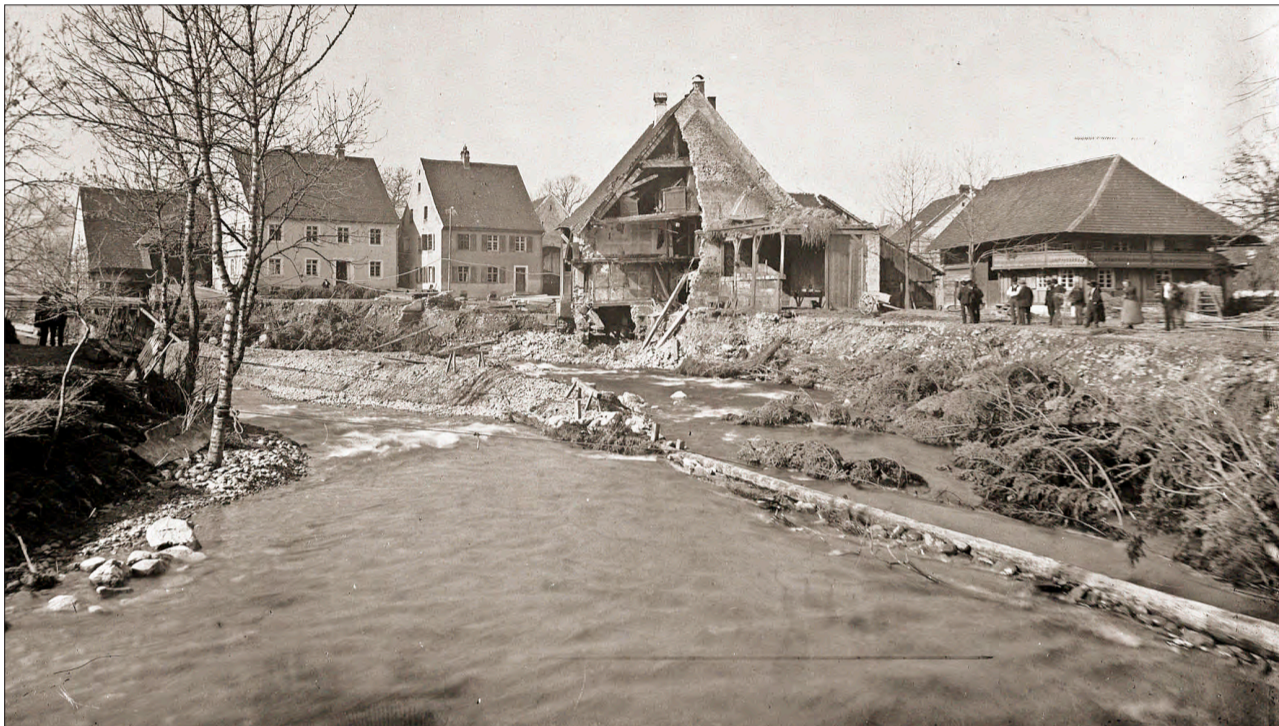
Blick auf das Anwesen Birkenmeier, links daneben sind Mauerreste des Pfisterschen Anwesens erkennbar, ganz links die Brücke über die Dreisam. Verwittertes Bildstöckle am Pfändlerhof (rechts): Es wurde in Gedenken an das Hochwasser 1896 aufgestellt. FOTOS: STADTARCHIV FREIBURG/DARGLEFF JAHNKE
