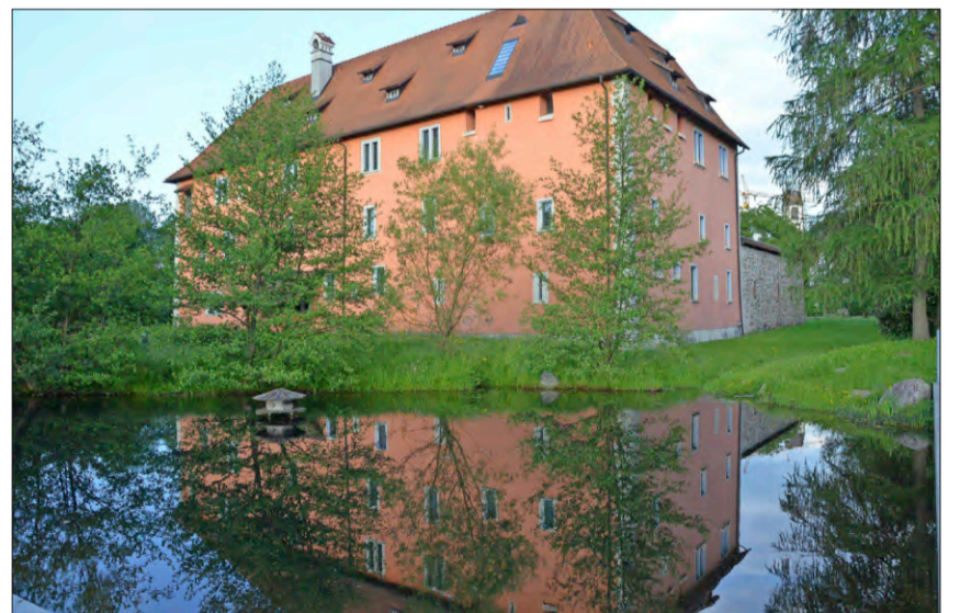
In der Talvogtei in Kirchzarten fanden die ersten Vernehmungen der als Hexen denunzierten Menschen durch den Talvogt statt. FOTO: MARKUS DONNER
