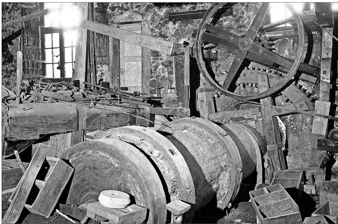
Wellbaum im Innenraum der Kienzlerschmiede 1965.
