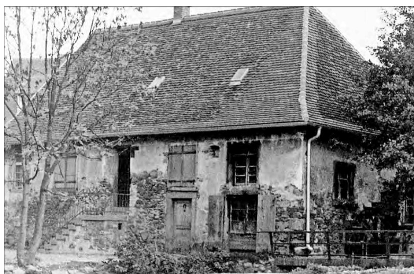
So präsentierte sich die Kienzlerschmiede vor den 1962 begonnenen Renovierungsarbeiten.
